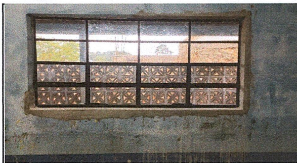
Foto 6: SUSTITUCIÓN DE VENTANAS
