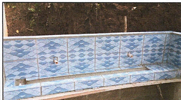
Foto 3: IMPERMEABILIZACIÓN DE LOSA (SANITARIOS)
