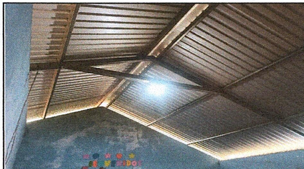
Foto 10: REPARACION DEL SISTEMA ELECTRICO
