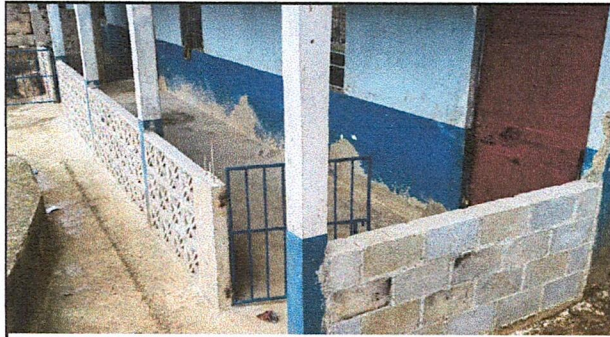
Foto 13: Colocación de celosía el contorno del corredor de la cocina
