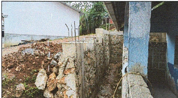
Foto 16: Reparación de muro de contención
