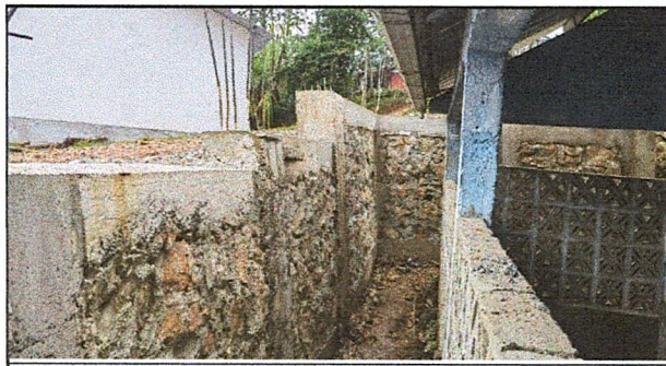
Foto 17: Reparación de muro de contención
