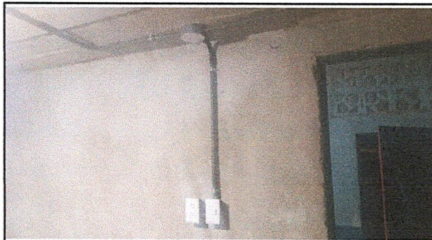
Foto 9: REPARACION DEL SISTEMA ELECTRICO
