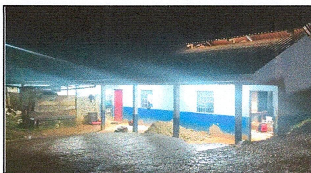
Foto 12: REPARACION DEL SISTEMA ELECTRICO
