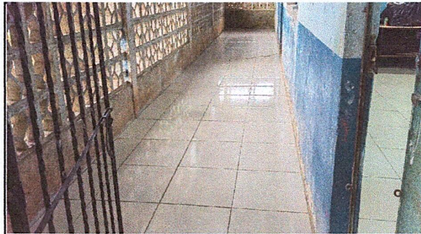
Foto 8: SUSTITUCION DE PISO
